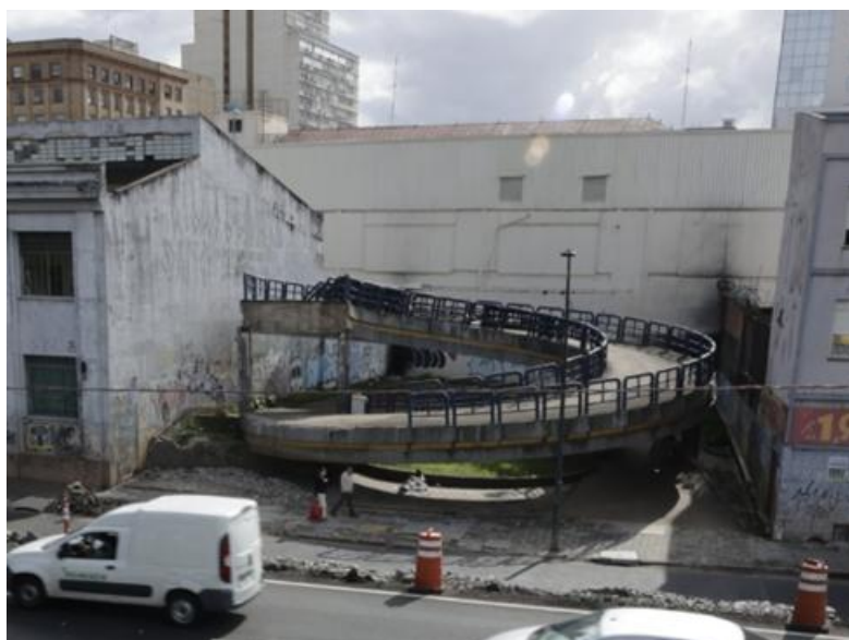
Avistamento de um dos acessos em espiral da passarela da Rodoviária de Porto Alegre sem o pavimento da passarela demolida em 10 de maio de 2024 para abertura de corredor humanitário que voltara a ser, tempos depois, a própria Avenida Castelo Branco, antiga Avenida da Legalidade, desta vez elevada ao nível do chão. Fotografia: Tânia Meinerz. Fonte: Instagram do Jornal do Comércio, 19 dez. 2024.
